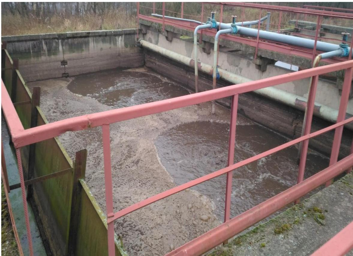
**Рисунок 49 Минерализатор**
