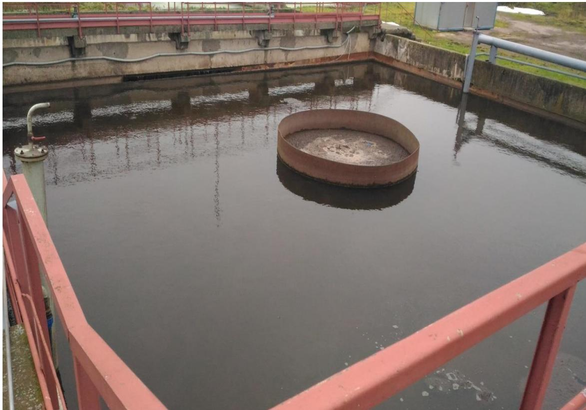
**Рисунок 50 Вторичный отстойник**
