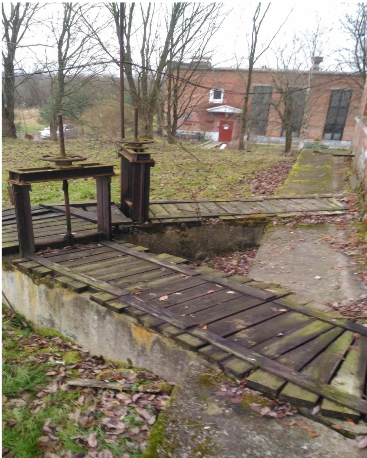
**Рисунок 45 Камера переключения**
