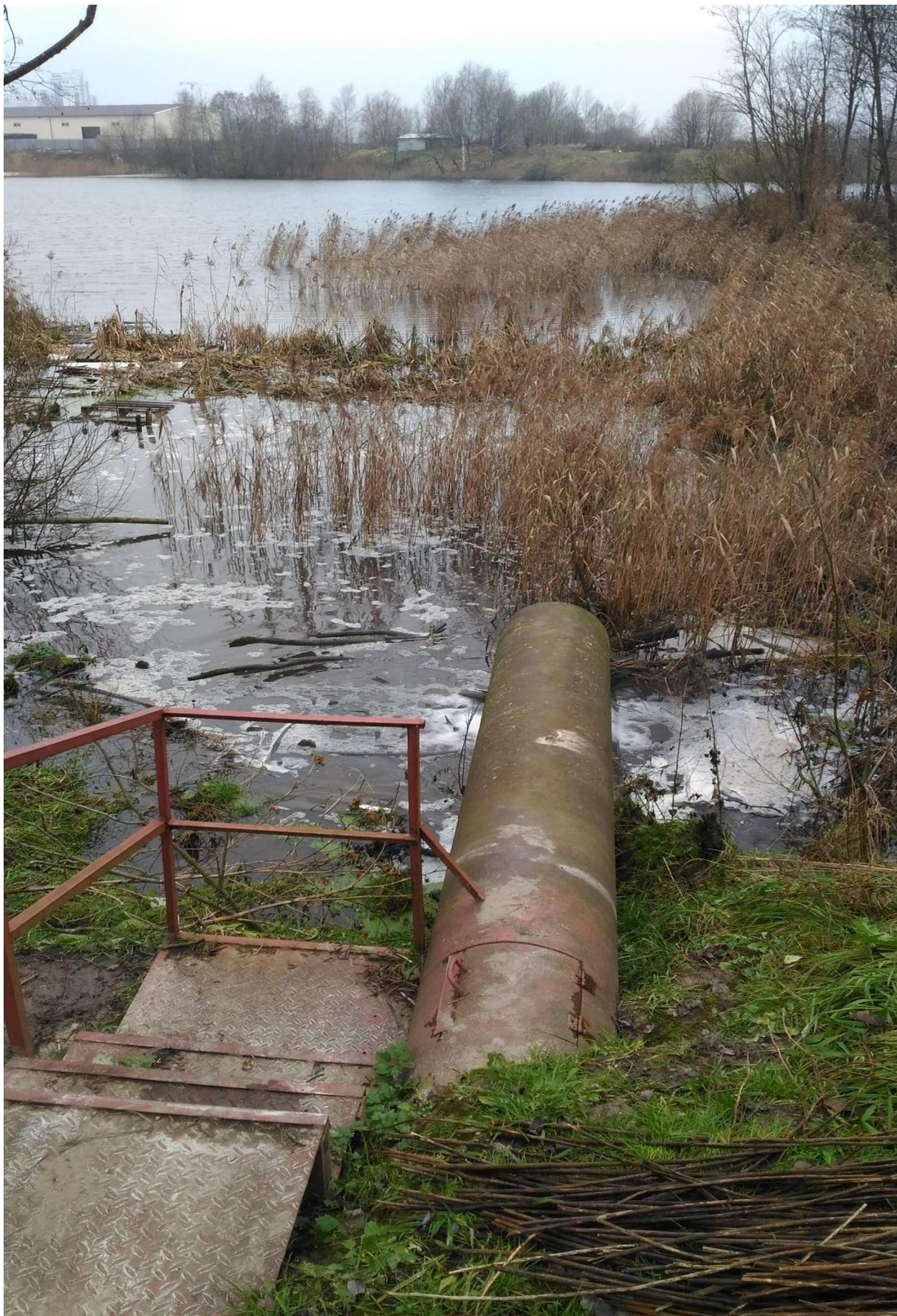
**Рисунок 53 Сбросной оголовок**
